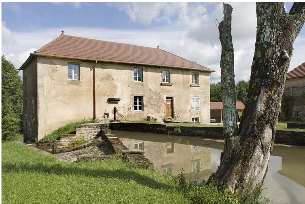
Façade sud du moulin.
