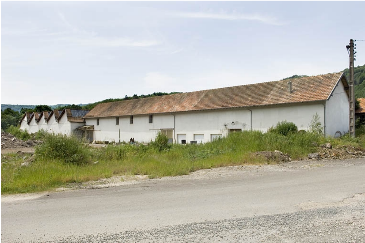
Atelier de fabrication (boulonnerie) depuis l'est.
