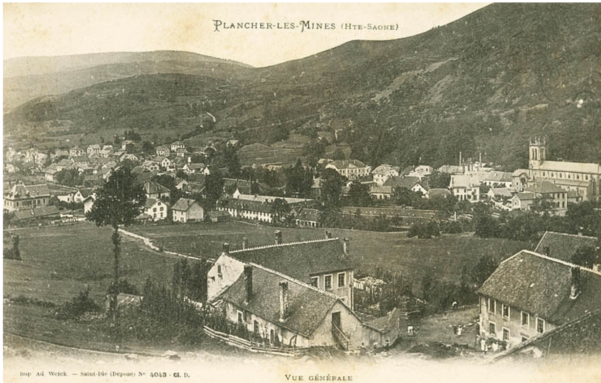
Plancher-les-Mines (Hte-Saône)- Vue générale.
