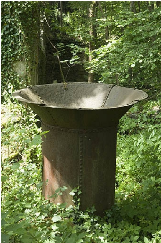
Couronnement métallique d'une cheminée en tôle.
