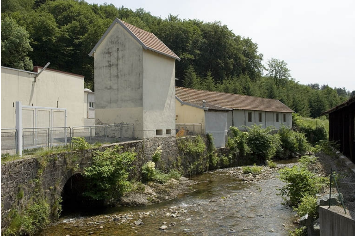
Bâtiments industriels depuis le pont d'accès.
