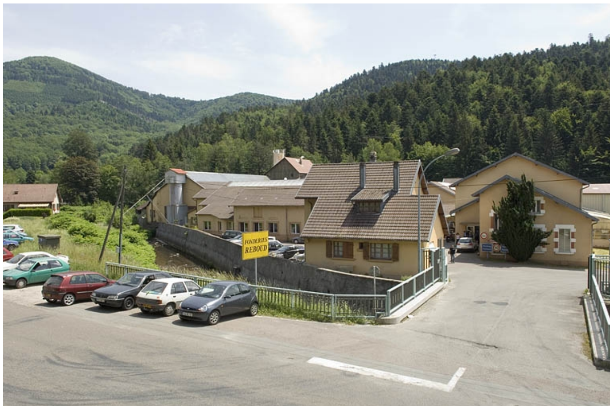
Partie nord de l'usine depuis l'entrée.
