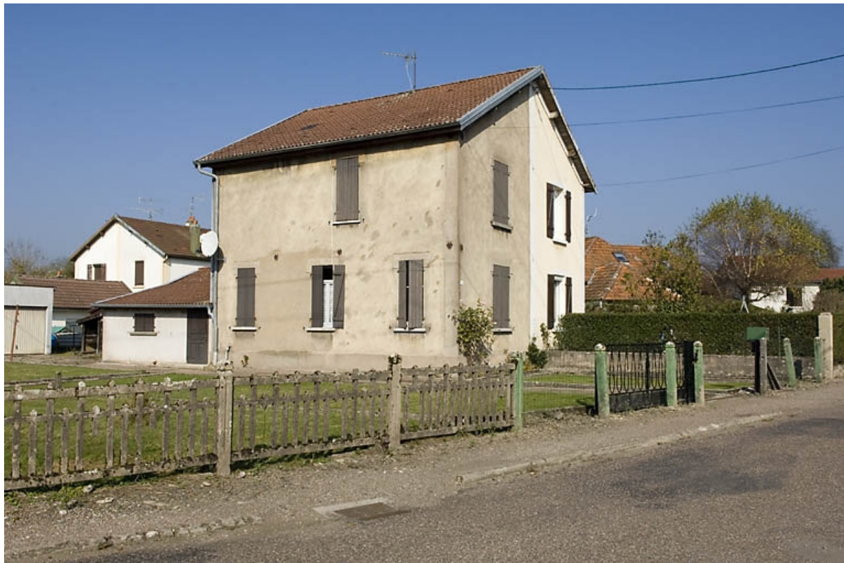
Maison double à étage (rue Jean Jaurès).
