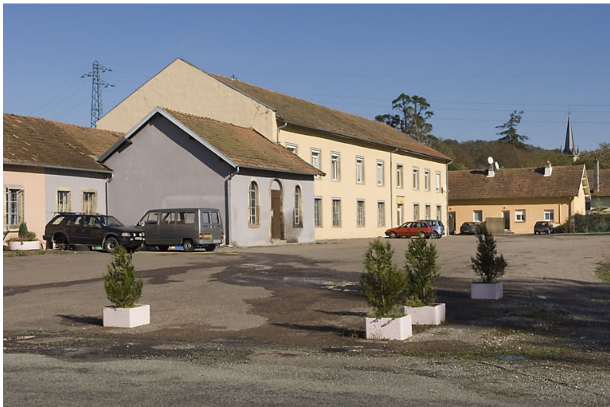
Façades sud. Chaufferie et atelier de fabrication (?).
