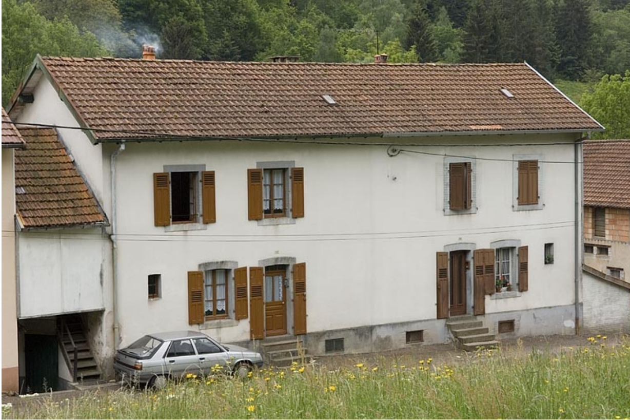
Logement ouvrier collectif (rue de l'Usine).
