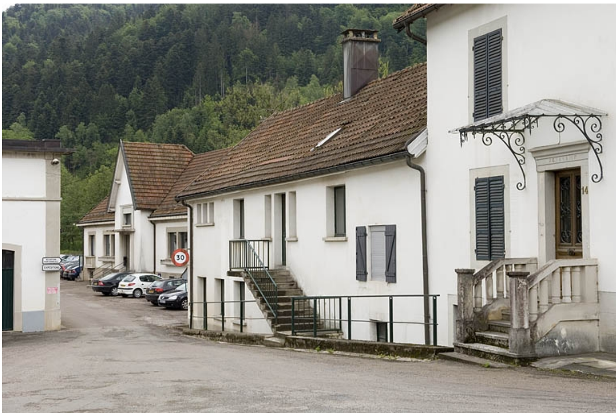
Les bureaux vus depuis l'entrée.
