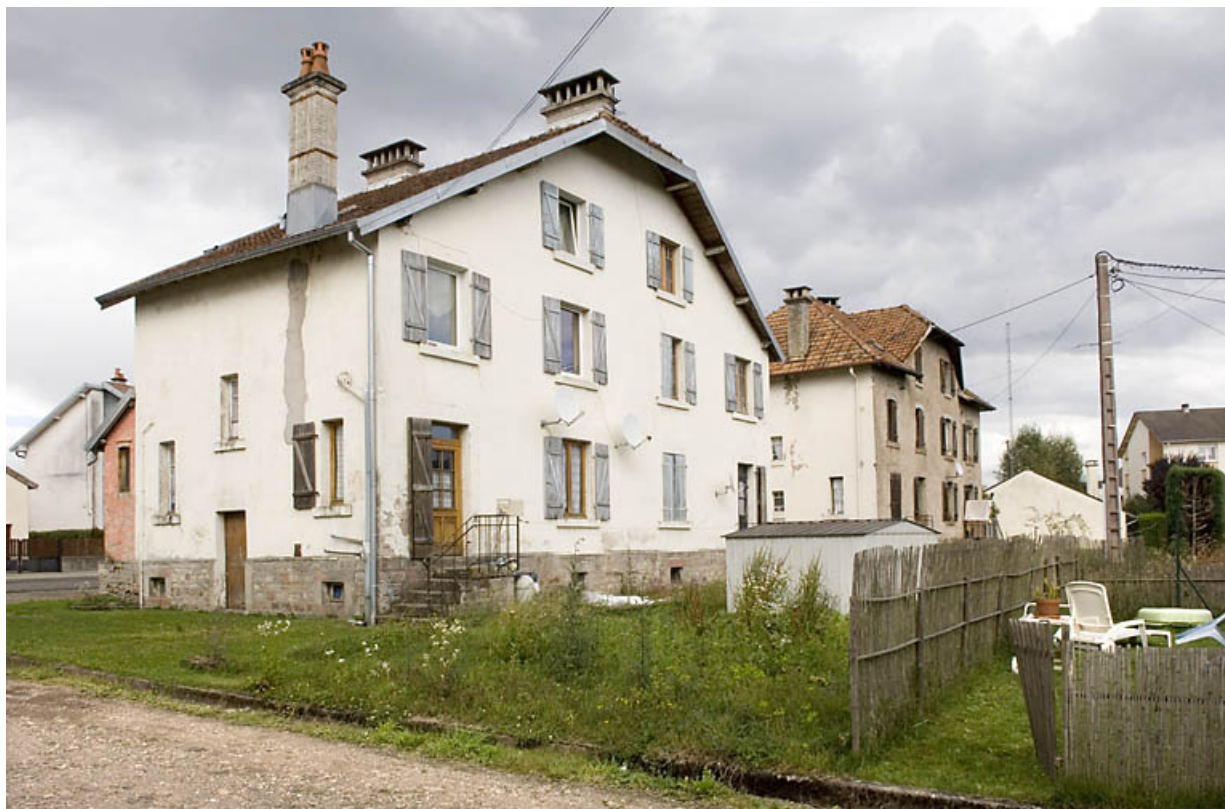
Façades postérieures des maisons ouvrières.
