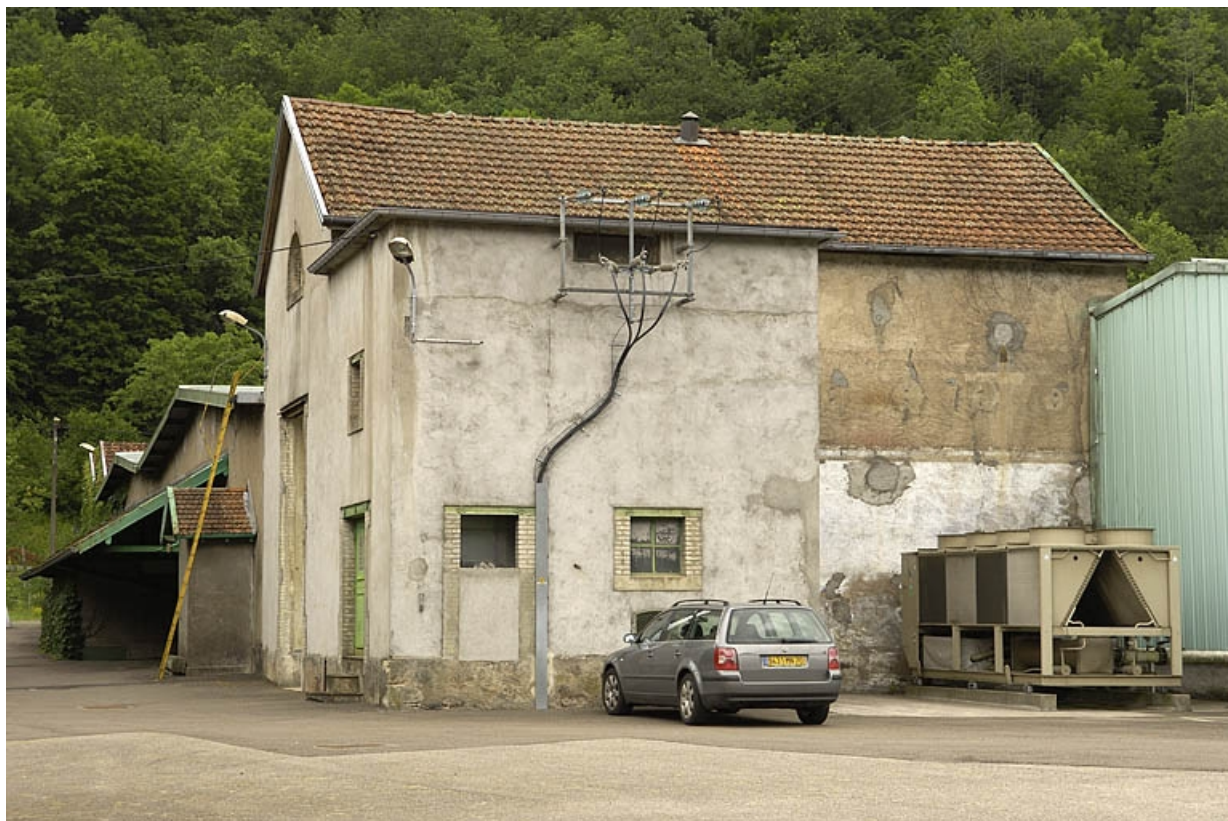
Transformateur et ancienne chaufferie.
