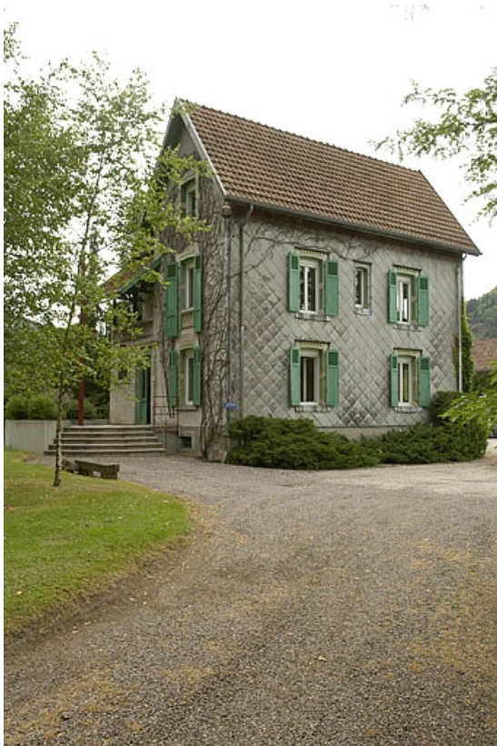
Ancien logement patronal. Vue depuis l'entrée.
