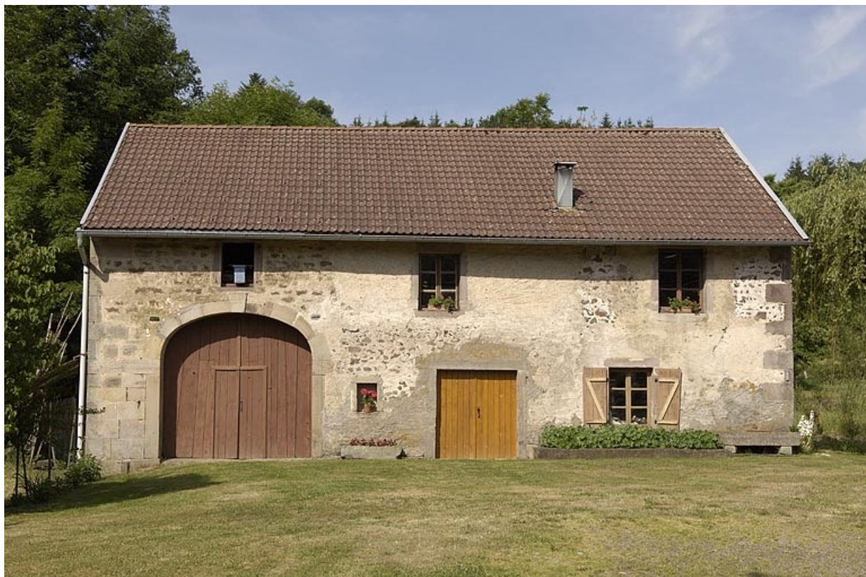
Façade est du moulin.
