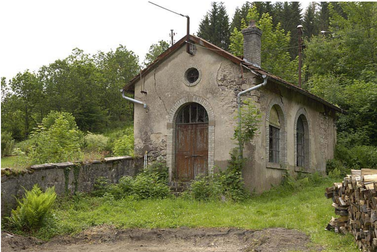
Ancienne centrale hydroélectrique.
