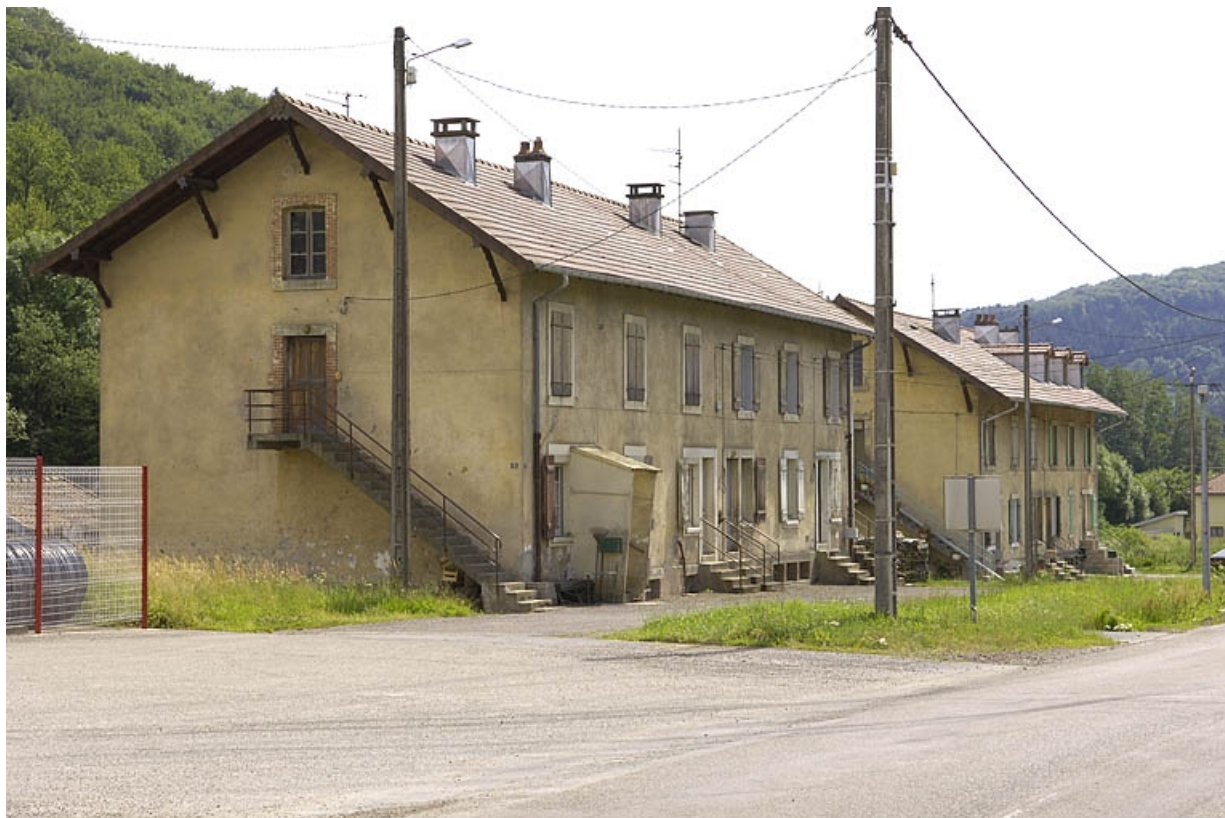
Vue d'ensemble des logements ouvriers.
