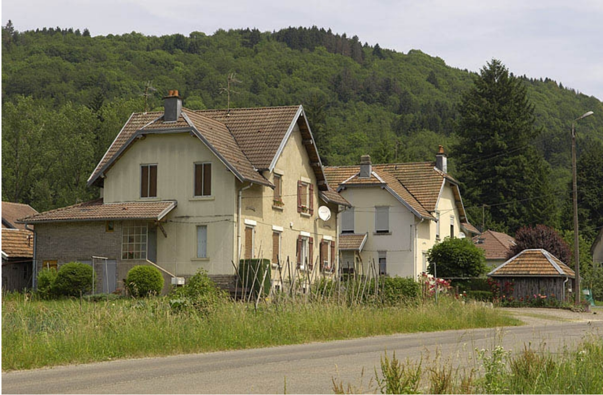
Vue d'ensemble des logements de contremaître.
