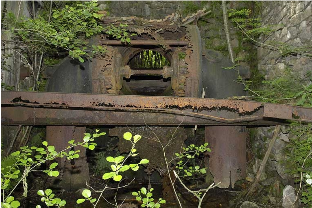
Turbine hydraulique à axe horizontal. Vue rapprochée.
