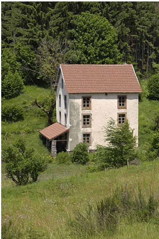
Façade sud du moulin.
