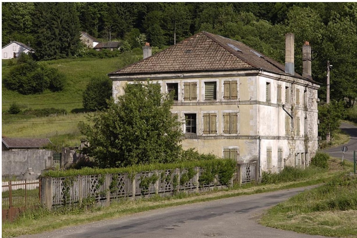
Ancien logement ouvrier vu depuis le sud-est.
