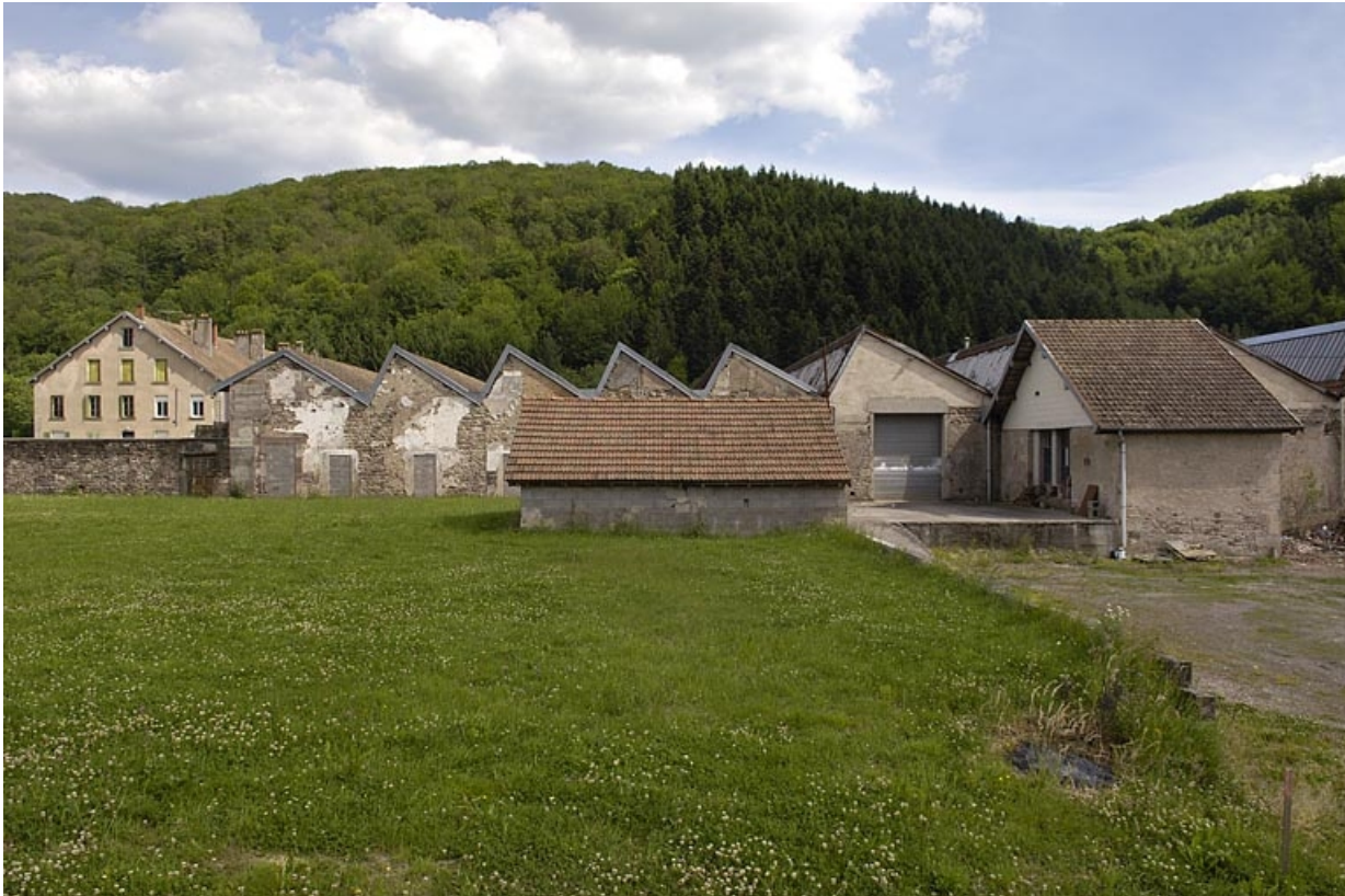
Pignons des ateliers de filature.
