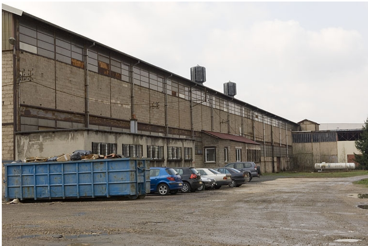
Façade nord de l'atelier de fabrication.
