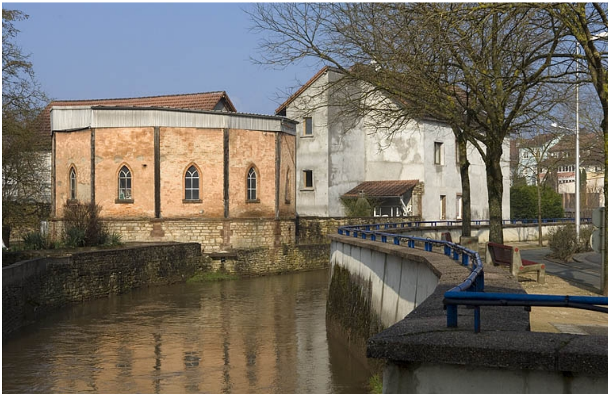
Vue d'ensemble en aval de la Lizaine.
