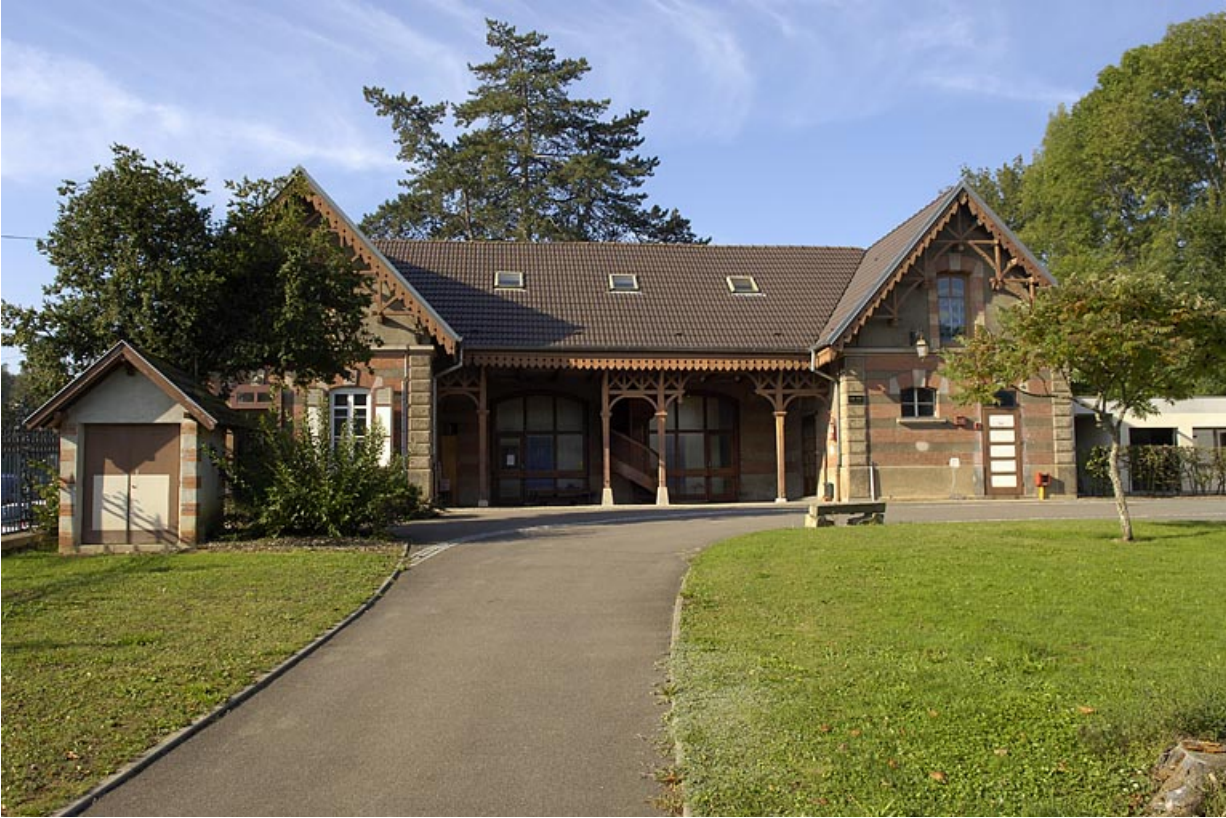
Façade nord de l'ancienne écurie (?).
