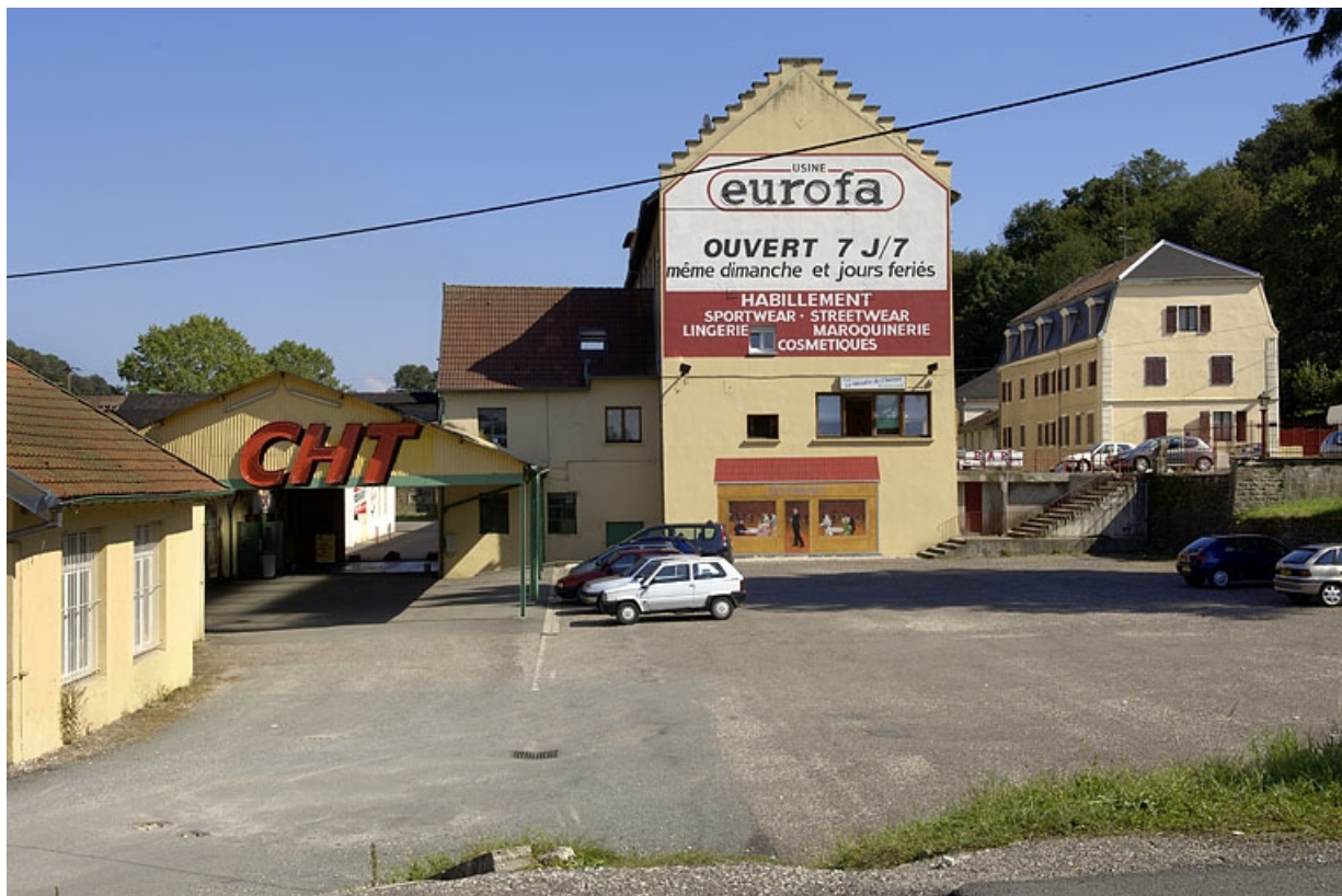
Ateliers de fabrication depuis l'ouest.
