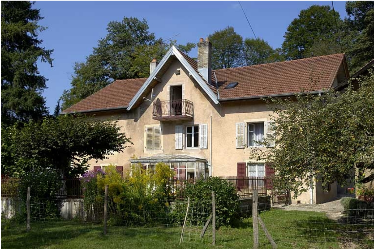
Façade sud du moulin.
