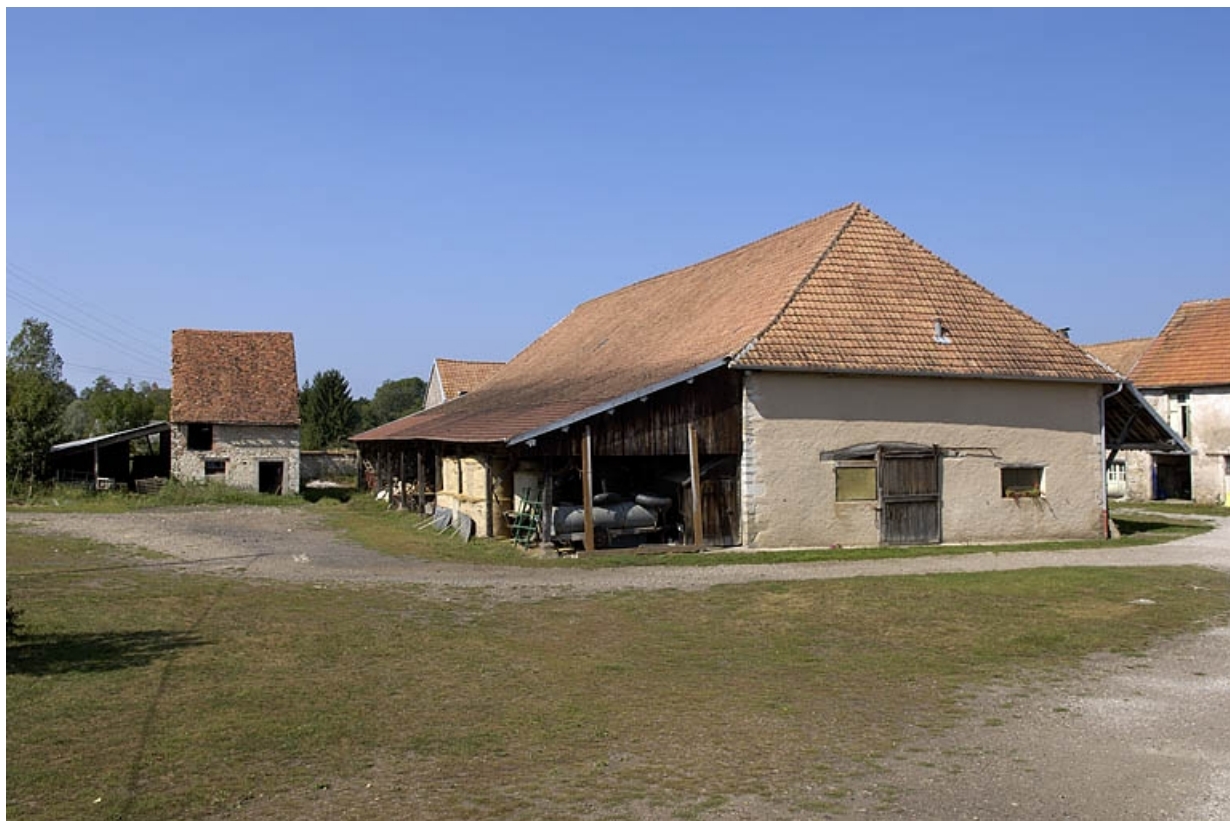
Vue depuis le sud-ouest de la cour.
