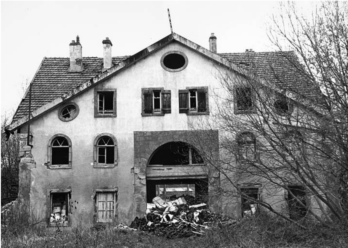
Bâtiment d'entrée ouest en 1977. Façade postérieure.
