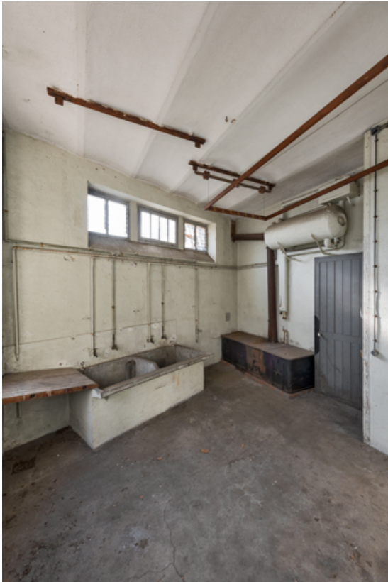
Vue intérieure de la buanderie.
