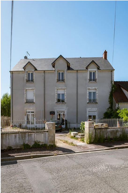
Façade depuis la rue de Bourgneuf.
