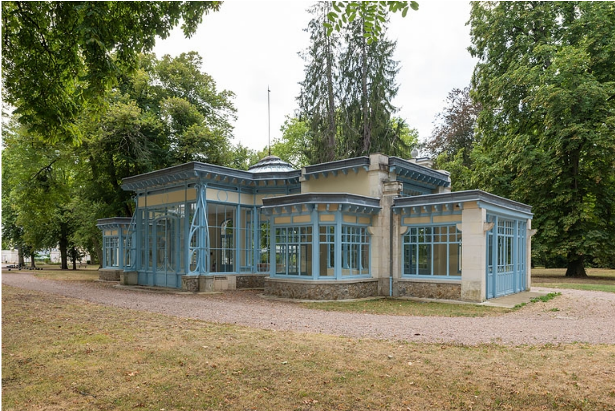
Façade est, vue en 2020.
