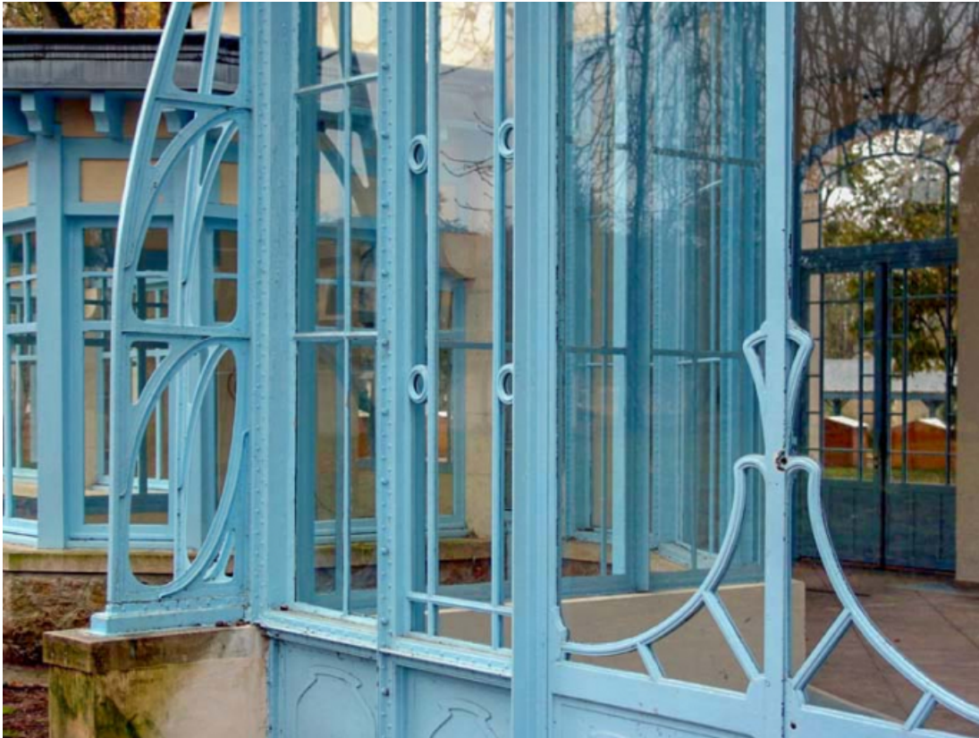
Façade est, vue en 2005.
