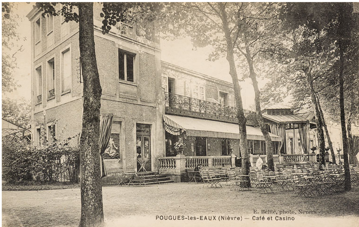
Bâtiment du cercle, vue extérieure.
