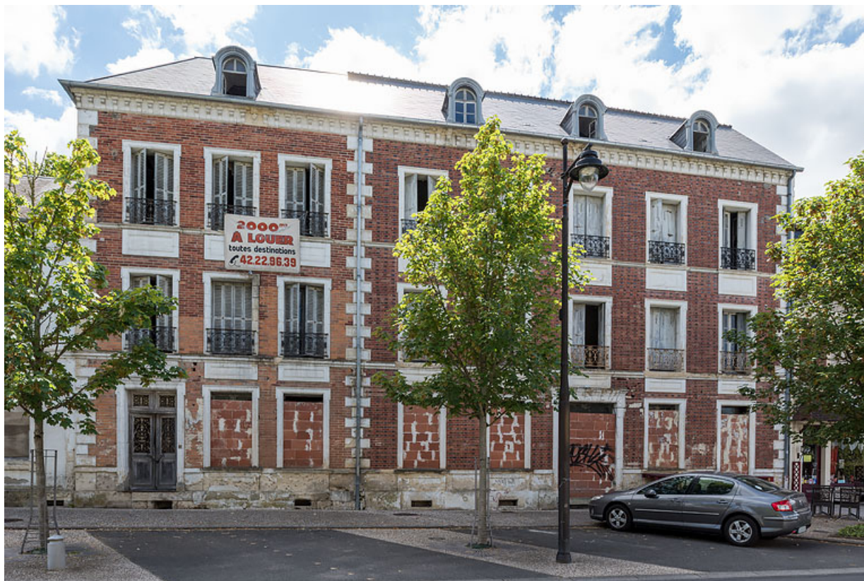
Façade de l'extension de Jules Guimard.
