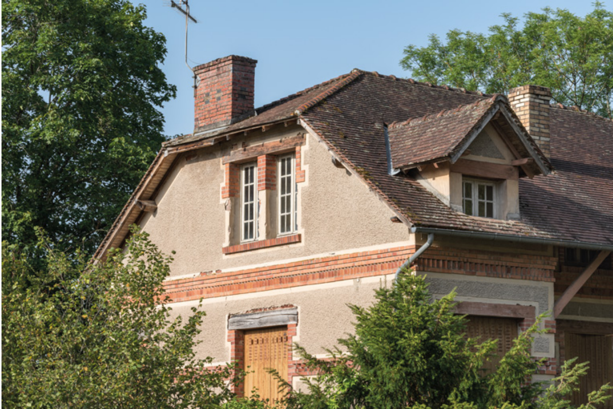
Détail de la toiture, demi-croupe et lucarne.
