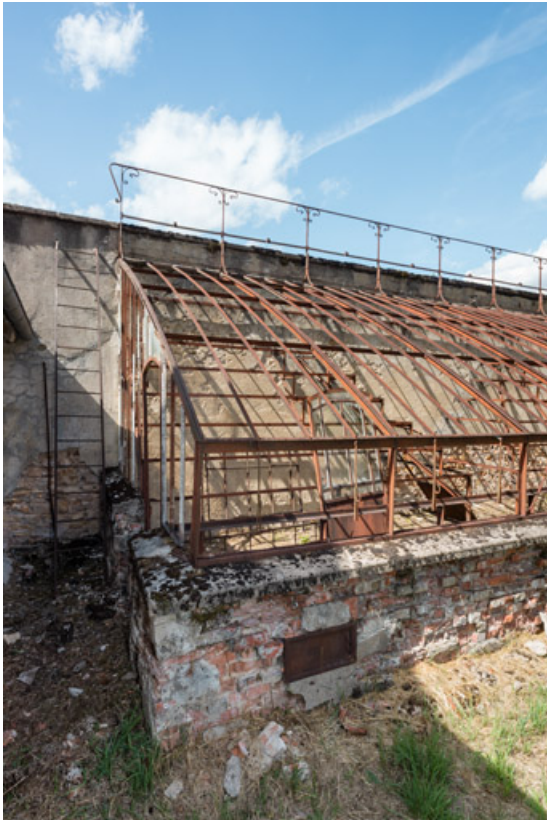
Détail de la structure métallique construite sur un muret en brique et adossée à un mur en calcaire. 58, Saint-Honoré-les-Bains, 8 avenue de Rémyilly
