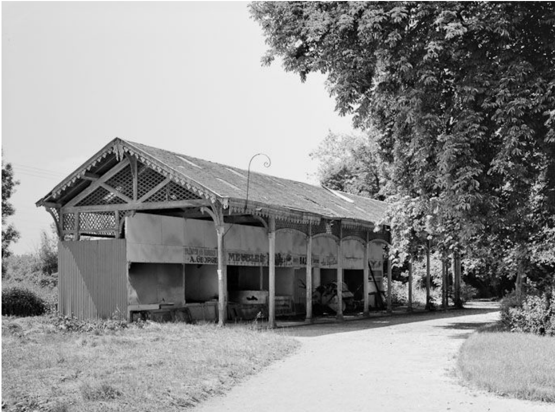
Ancien promenoir avec boutiques.
