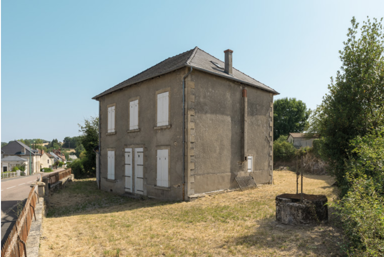
Façade principale, vue depuis le sud-ouest.
