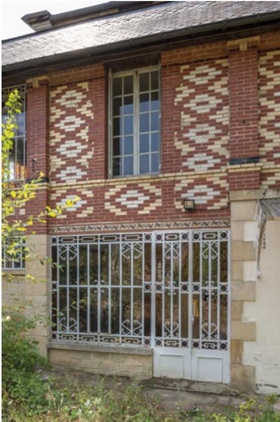
Élévation de l'extension en brique, côté nord.
