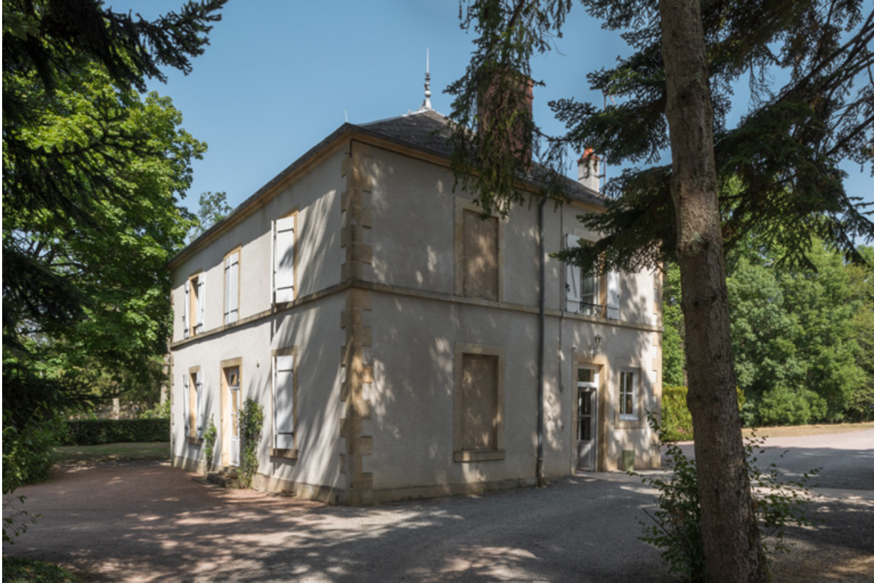
Vue de la villa depuis le sud-est.
