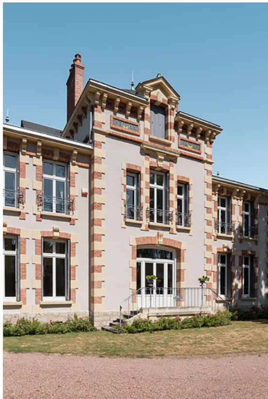
Avant-corps central de la façade principale.
