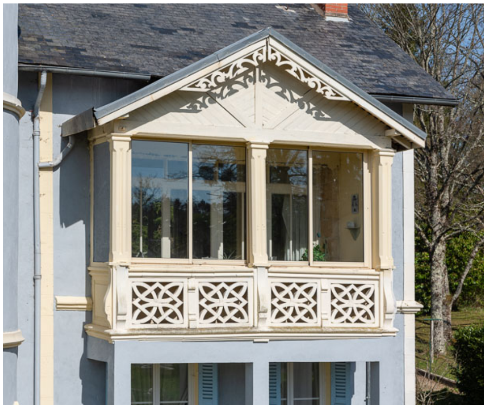
Façade sud-est, oriel.
