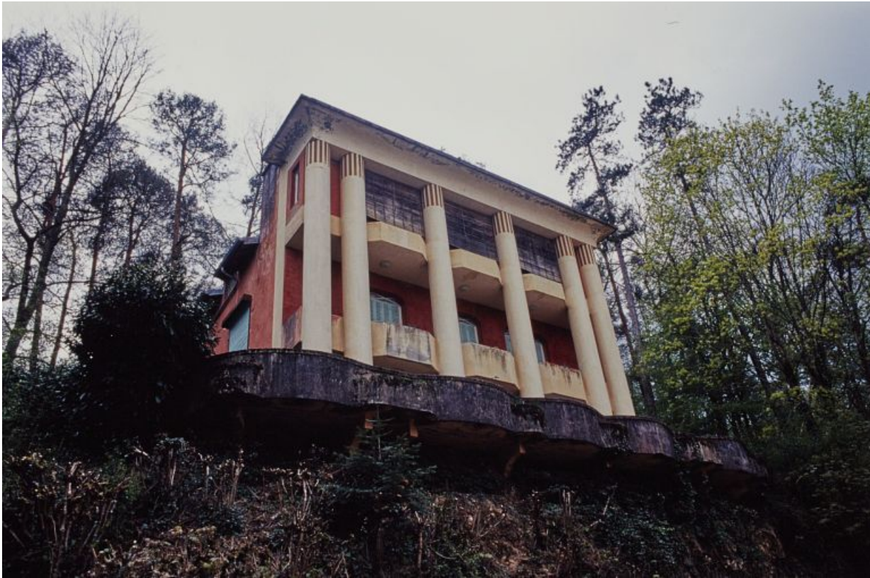
Façade nord, vue en contre-plongée.
