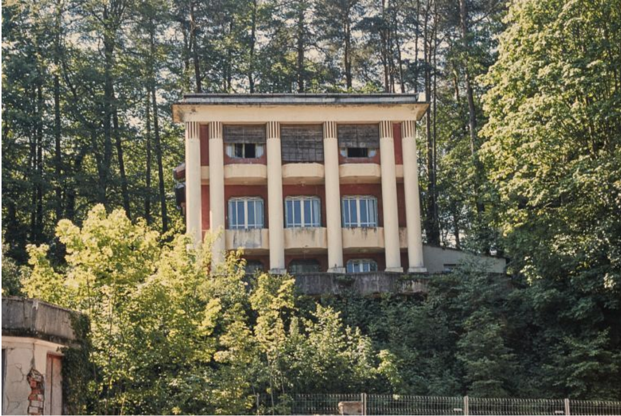
Façade nord, vue de face.
