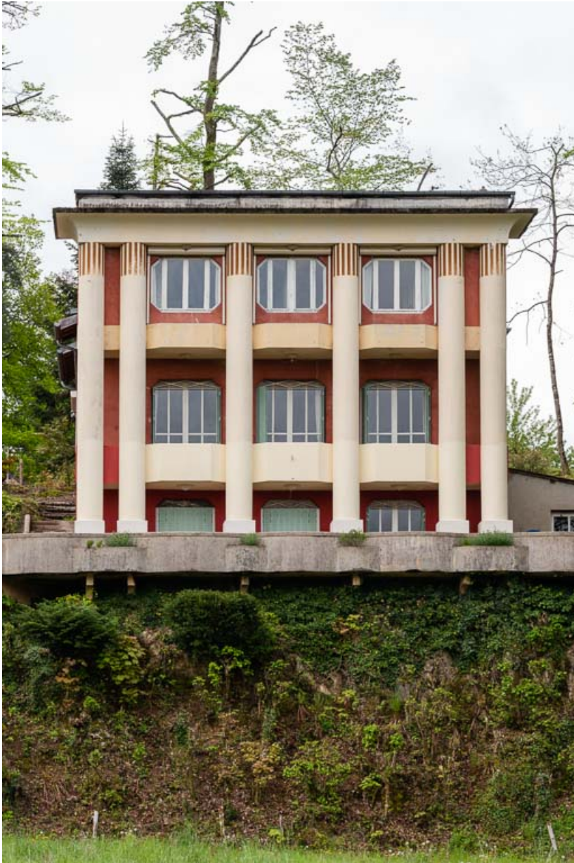
Façade nord, vue de face.
