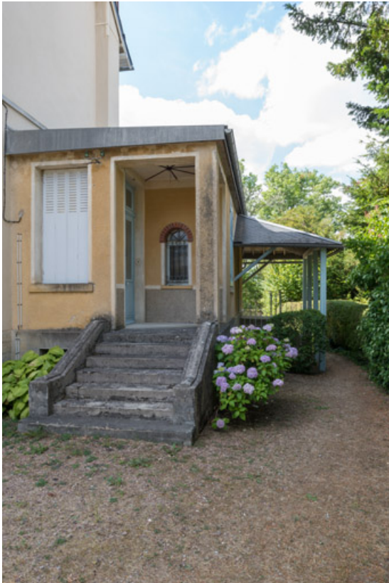
Entrée latérale, côté nord.
