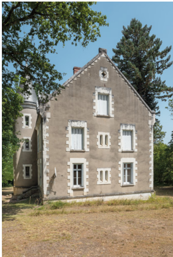
Mur pignon sud-ouest.
