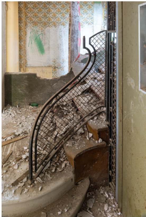
Escalier ouest, détail, rampe d'appui.
