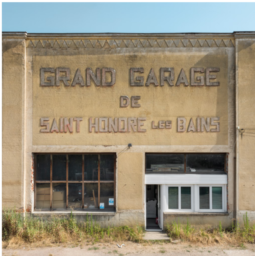
Travée centrale de la façade.
