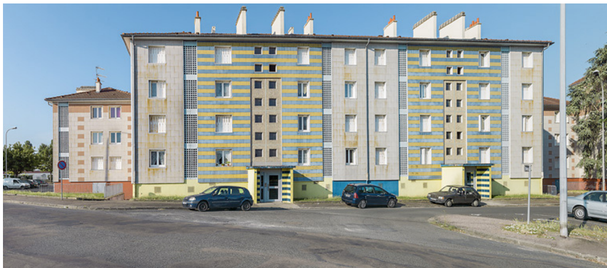
Bâtiment A, façade antérieure est.
