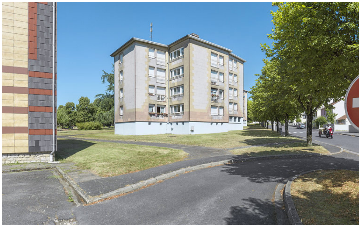
Bâtiment Million-1, façade postérieure sud.
