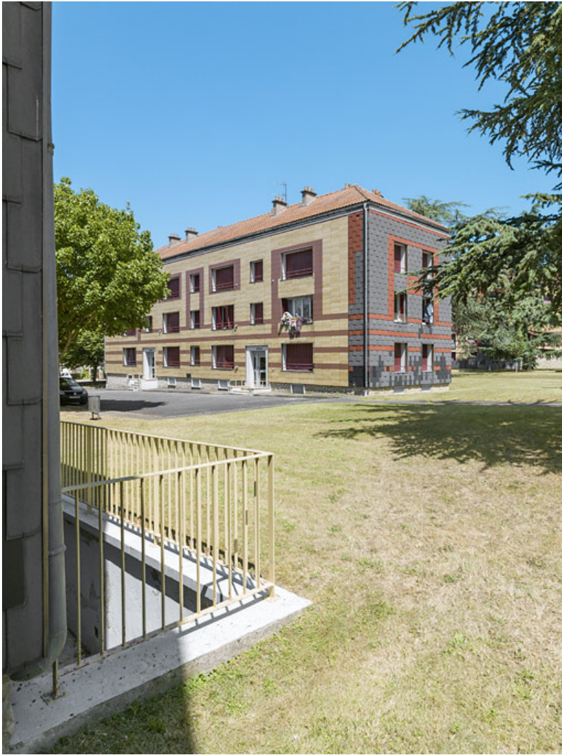
Bâtiment Binot-A, façade antérieure.
