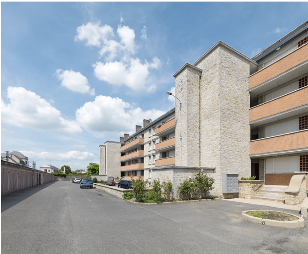
Façade antérieure du bâtiment A.
