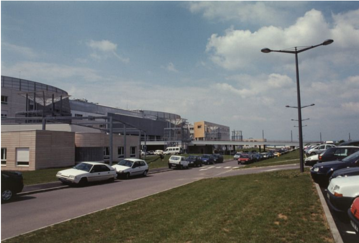
Façade antérieure, vue d'ensemble.
