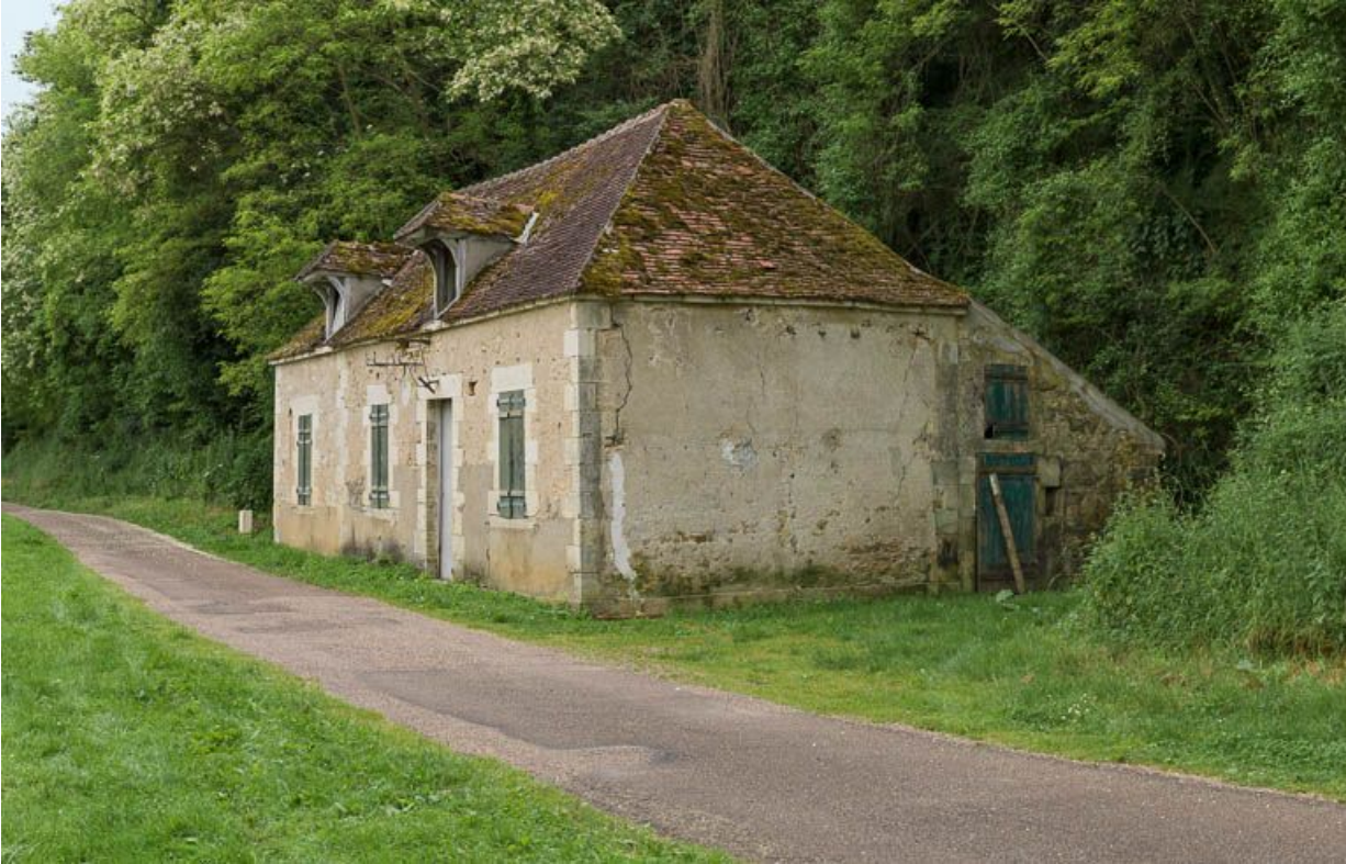
Vue de 3/4 de la maison éclusière.
