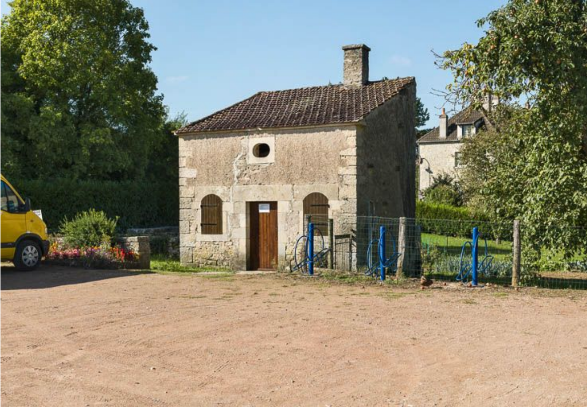
L'abri des ouvriers : vue de 3/4.
