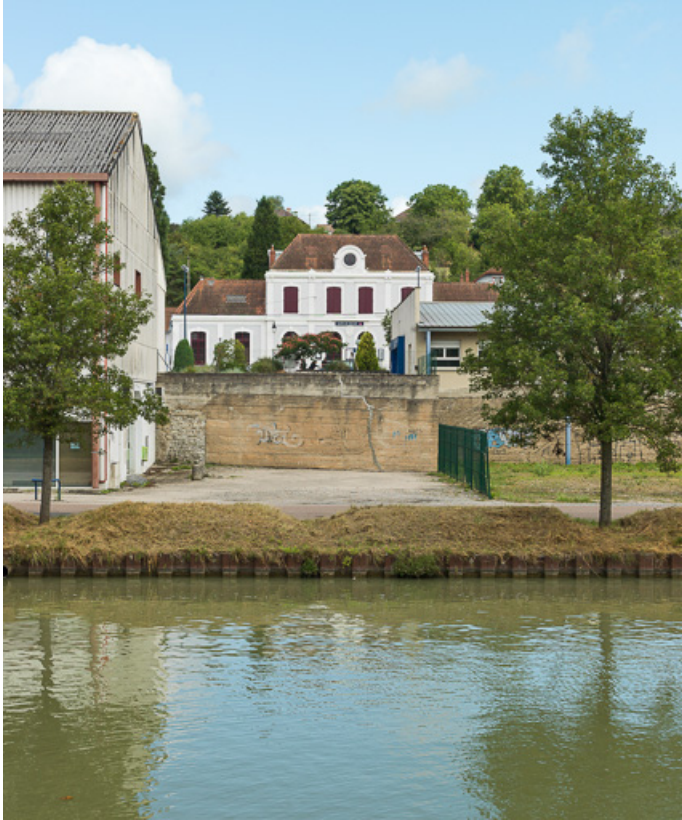
Vue de la gare et du canal.
